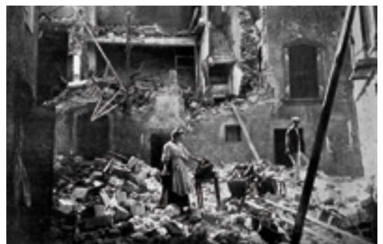
Dégâts occasionnés par le séisme de Lambesc, le 11 juin 1909 qui fit quarante-six morts : intensité estimée au degré 9 sur l'échelle MKS et magnitude, à 6,2 sur l'échelle de Richter
