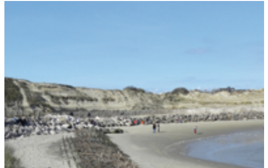
Digue en pierre ou perré, en protection du littoral de Berck (Pas-de-Calais) © Elise Tremel
