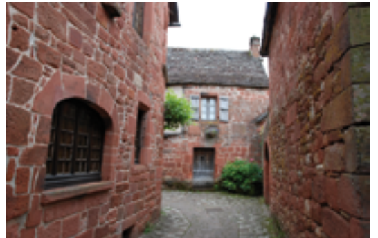
Collonges-la-Rouge, village classé de Corrèze, construit en grès arkosique daté du Permien. Le sable à l'origine de cette arkose provenait, à cette époque, de l'érosion de la chaîne hercynienne au niveau du Massif central
