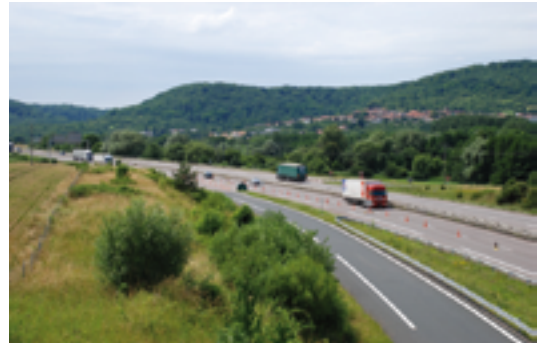
Rebord (cuesta) de la côte de Moselle dominant l'A4 au nord de Metz (Moselle)
