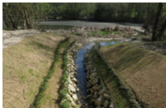
Aménagement des berges du ru du parc de la Noisette à Antony (Hauts-de-Seine)
