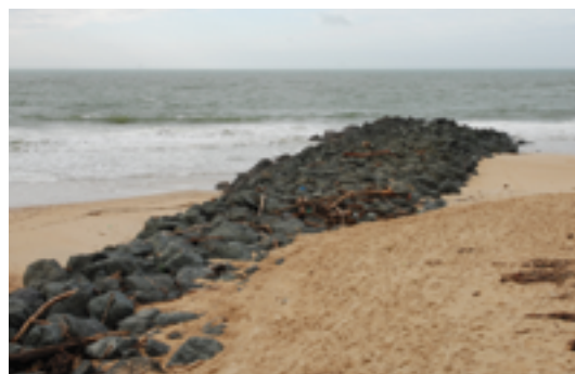
Épi en pierres au Cap Breton, le long du littoral landais
