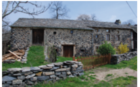
Toiture et dessus de muret en lauzes de schistes (Auvergne)
