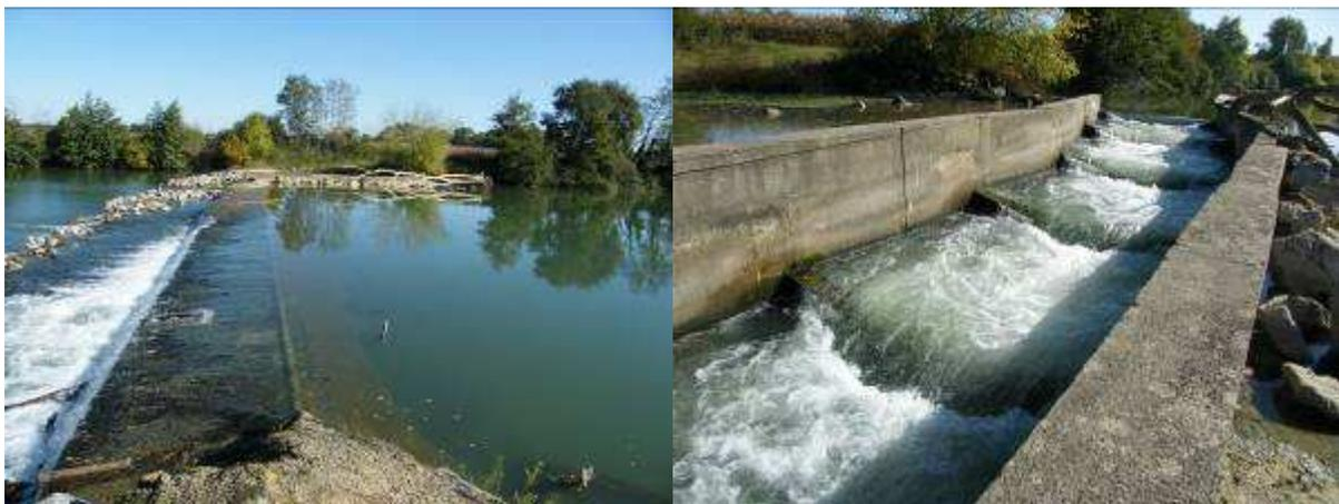
*Photos 48 et 49 : Seuil établi en lit mineur de l'Adour avec sa passe à poissons*
