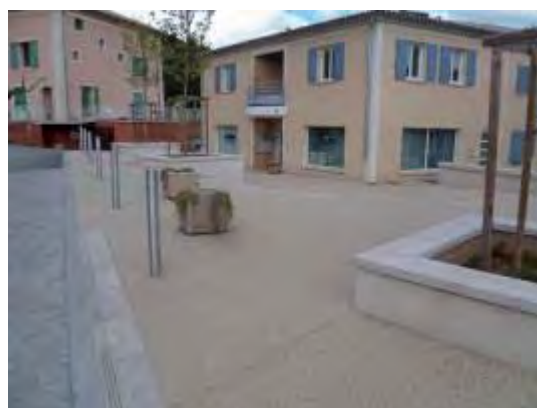
Commune de Villeneuve
