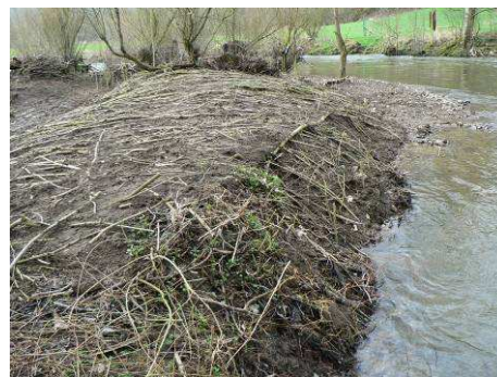
Photo 54. Tapis vivant de saule, réalisé sur berge, après talutage.
