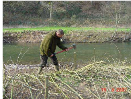
Photo 50. Placement des pieux en damier.
