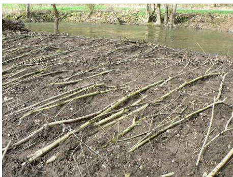
Photo 53. Apport de terre pour combler les interstices entre les perches.
