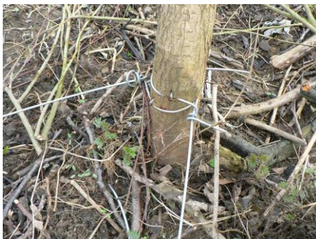
Photo 51. Fixation du fil de fer galvanisé aux piquets.
