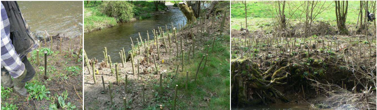
Photos 44 - 46. Plantation de boutures de saules à l'aide d'une barre à mine, selon une densité de 4 – 5 boutures /m 2
