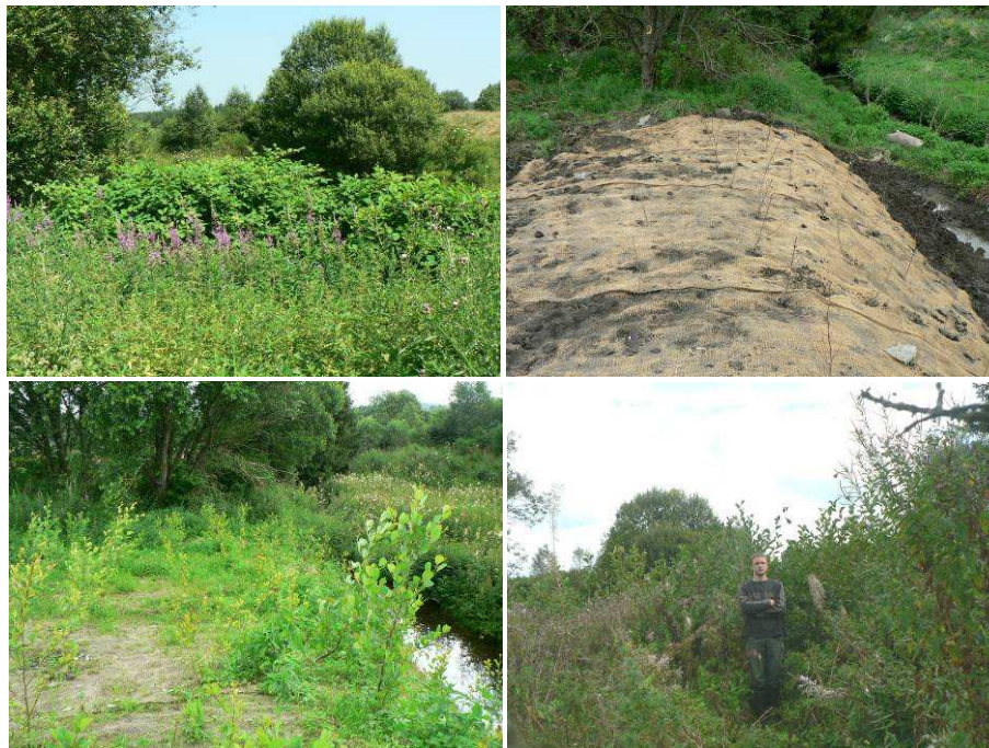
Photos 65 - 68. Evolution d'un site géré par la plantation de plants à racines nues d' Alnus glutinosa (S2R2) sur berge talutée et structurée par une natte de coco: état initial (haut gauche), chantier terminé (haut droite), après une saison de végétation (bas gauche) et après dégagements de la renouée, après deux saisons de végétation (bas droite).
