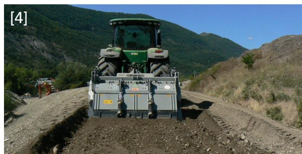
Concassage de terres contaminées hors site avec un broyeur de pierres
