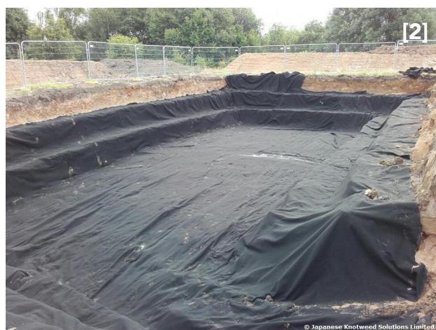
*Les terres contenant des fragments de rhizomes de renouées asiatiques peuvent être décontaminées par la technique du concassage-bâchage (à gauche) ou être enfouies sur site dans une cellule de confinement au sein d'un géotextile (à droite).*
