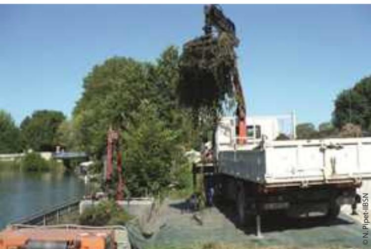
Installer une bâche au sol entre le bateau et la camion-grue permet de ne pas disperser des fragments de plantes sur la berge et éviter un retour à la voie d'eau.
